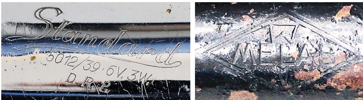
Bild 9.4: Beschriftungen: a) Typenbezeichnung und Nenndaten auf dem Gehäusemantel, b) Firmenlogo auf der Abdeckung der Kippvorrichtung
