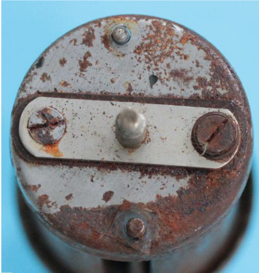
Bild 6.24: Magnetischer Rückschluss (Joch): a) Kontaktbrücke auf der Unterseite der Jochschüssel, b) Viernutiges Jochinnenteil mit Lagerschale
