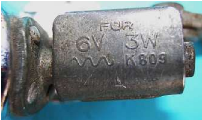
Bild 5.2: Beschriftung der Abdeckung mit den Nenndaten und der Prüfnummer
