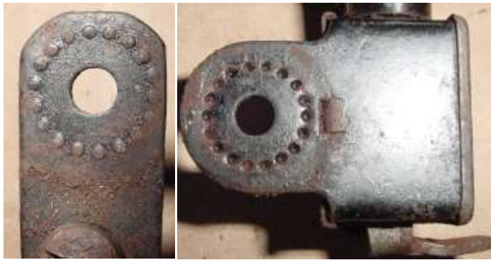
Bild 5.11: Nuten und Nocken zur Verzahnung im Haltergelenk
