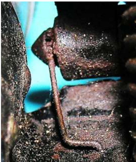
Bild 5.15: Drahtfeder in der Nut des Scharnierbolzens zur axialen Sicherung der Scharnierlappen
