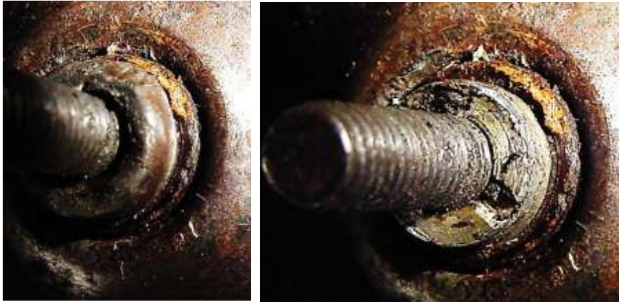
Bild 6.41: Befestigung des Stahlbodens am Kontaktbolzen
