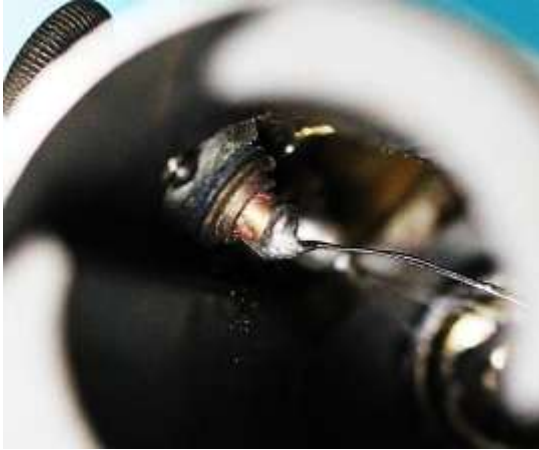
Bild 3.5: Lötstelle am Spannung führenden Kabelanschlussbolzen
