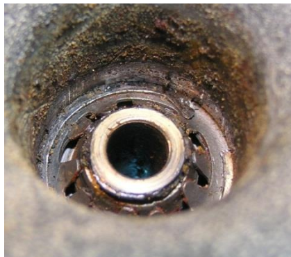
Bild 4.47: Kalottenlager im Lagerhals
