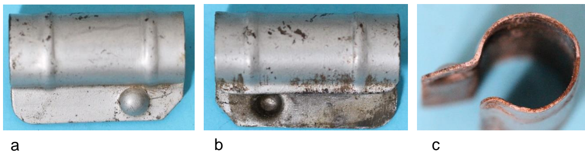
Bild 9: Abdeckblech: a) Nietausbeulung noch vorn, b) Nietausbeulung nach hinten, c) Stirnseite des Blechs
