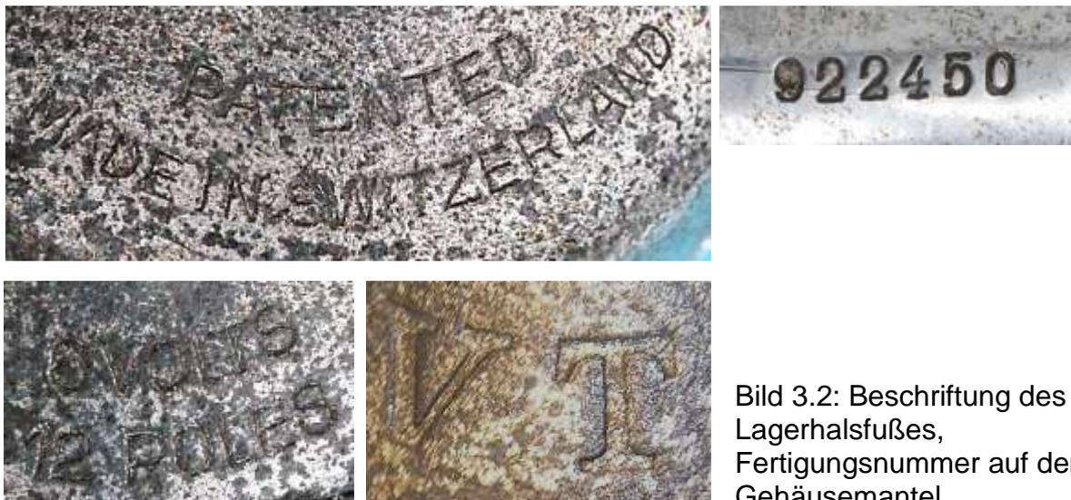
Bild 3.2: Beschriftung des Lagerhalsfußes, Fertigungsnummer auf dem Gehäusemantel
