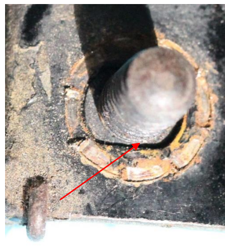
Bild 12.6: Halterbolzen: a) Position des Halterbolzens im Basisblech, b) Verdrehbarer Sitz des Halterbolzens
