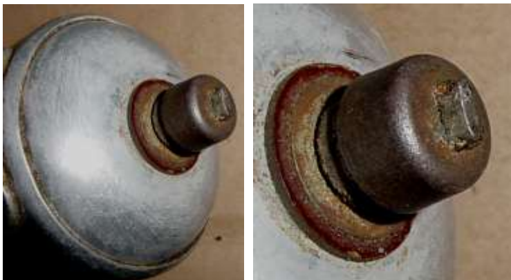
Bild 6.4: Klemmstelle für den Kabelanschluss
