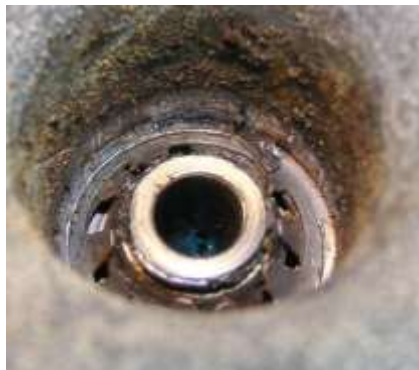
Bild 4.7: Kalottenlager im Lagerhals
